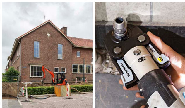
In het voormalig schoolgebouw wordt de bestaande dikwandige installatie aangepast en komen er 2 nieuwe ketelhuizen bij.
