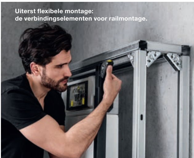
Prevista Dry Plus montage in de rails: de voet wordt op de rail geplaatst en vastgeklit.
