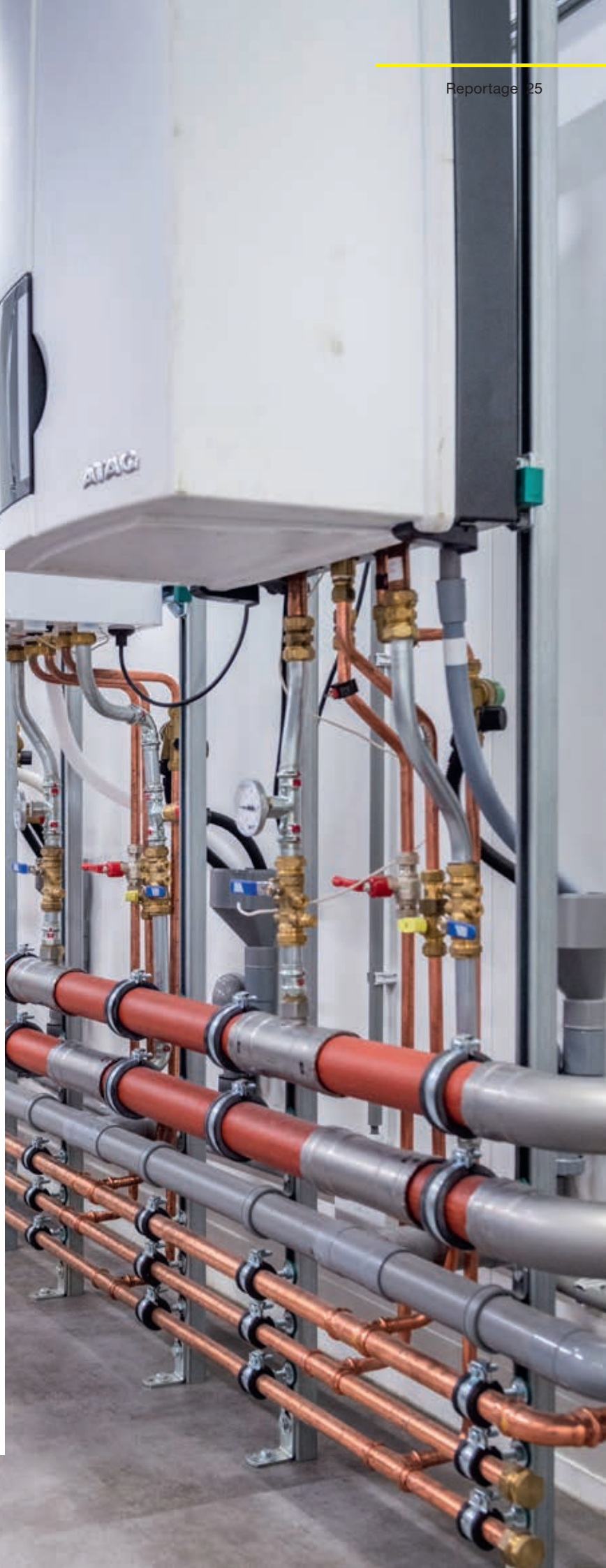
Naast Megapress koppelingen werden er Megapress XL flensen toegepast in de betreffende flatgebouwen.
