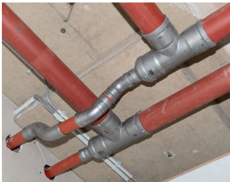
Het Megapress-systeem heeft een uitgebreid assortiment aan bochten, verloop-, overgangs- en T-stukken.
