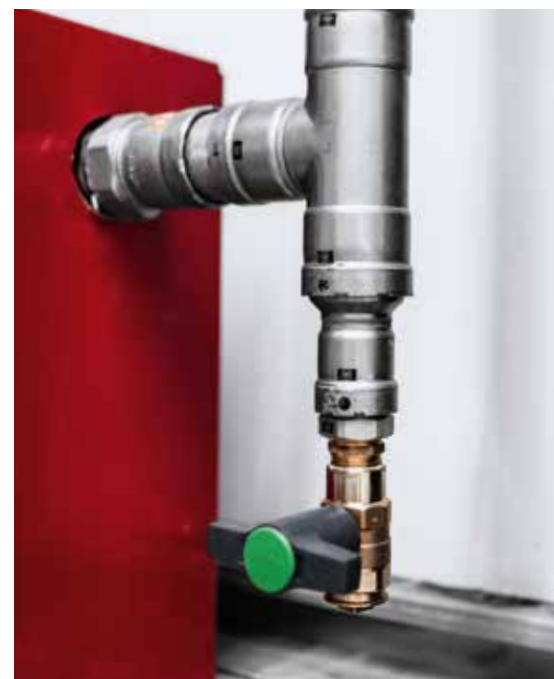
Volgens de norm: een brandblusinstallatie met Viega persverbindingen
