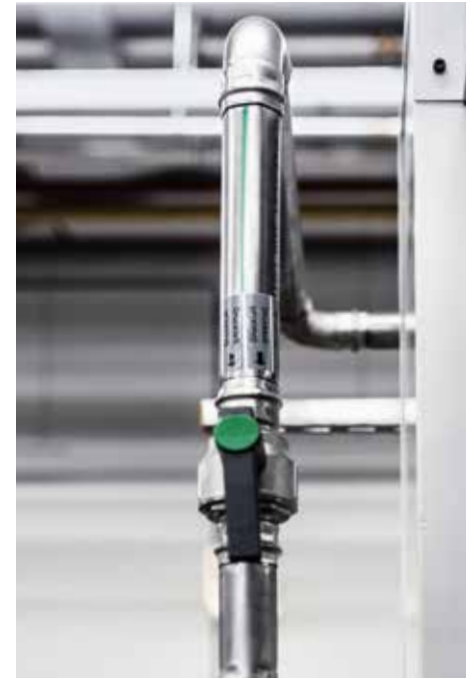
Betrouwbaar dicht: de koude Viega persverbindingstechniek.
