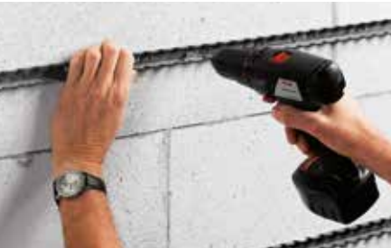
Montage van de klemrail De Side 12 klemrail wordt op de vaste wand gemonteerd.
