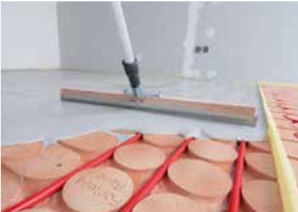
De innovatieve gietmassa Dankzij de uiterst vloeibare gietmassa is een snelle droging gegarandeerd. Al na 2 tot 4 uur is de vloer te belopen, na 24 uur kan hij worden bedekt met tegels, tapijt, pvc en na 3 dagen met laminaat en parket.
