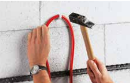
Montage in de bochten De buizen worden in lussen met spijkerclips gefixeerd.
