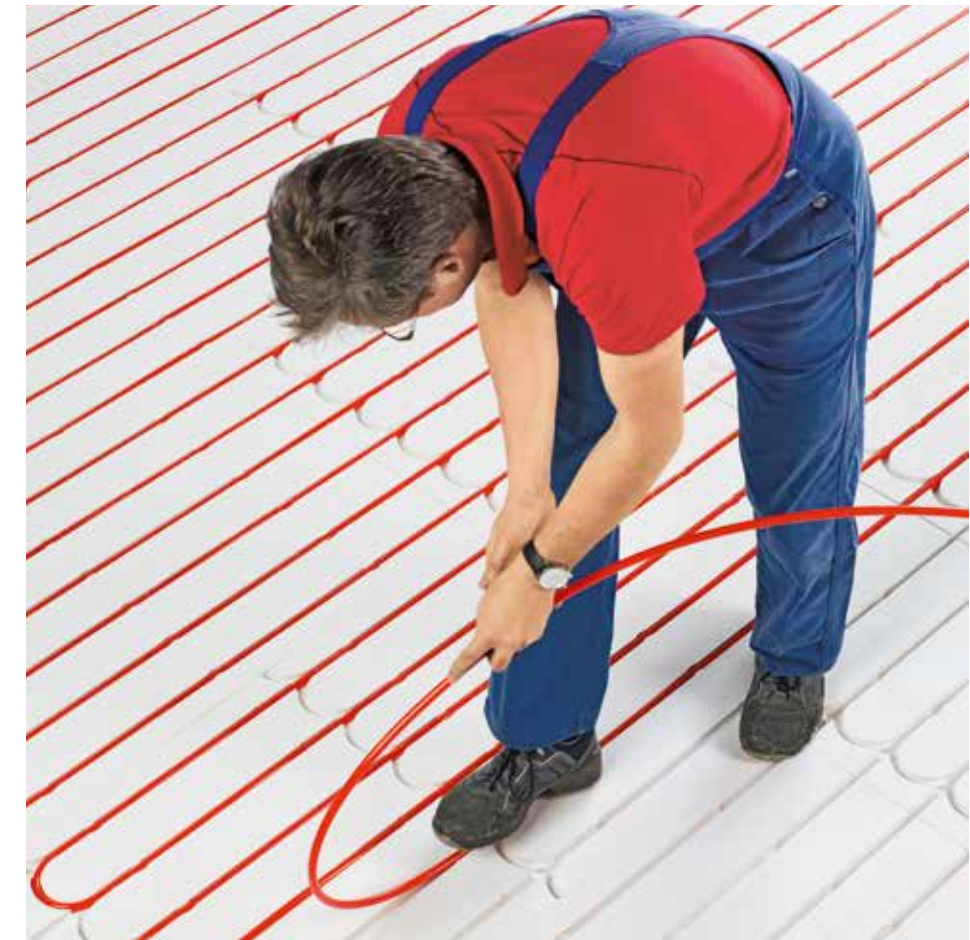
De flexibele Fonterra PB-buis garandeert het hoogste montagecomfort.
