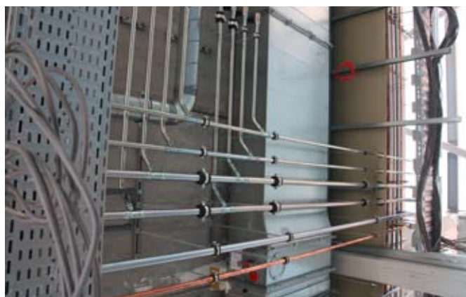
Het koperen Profipress-systeem en het verzinkt stalen Prestabo-systeem worden naast elkaar gebruikt en geperst met dezelfde persbekken.
