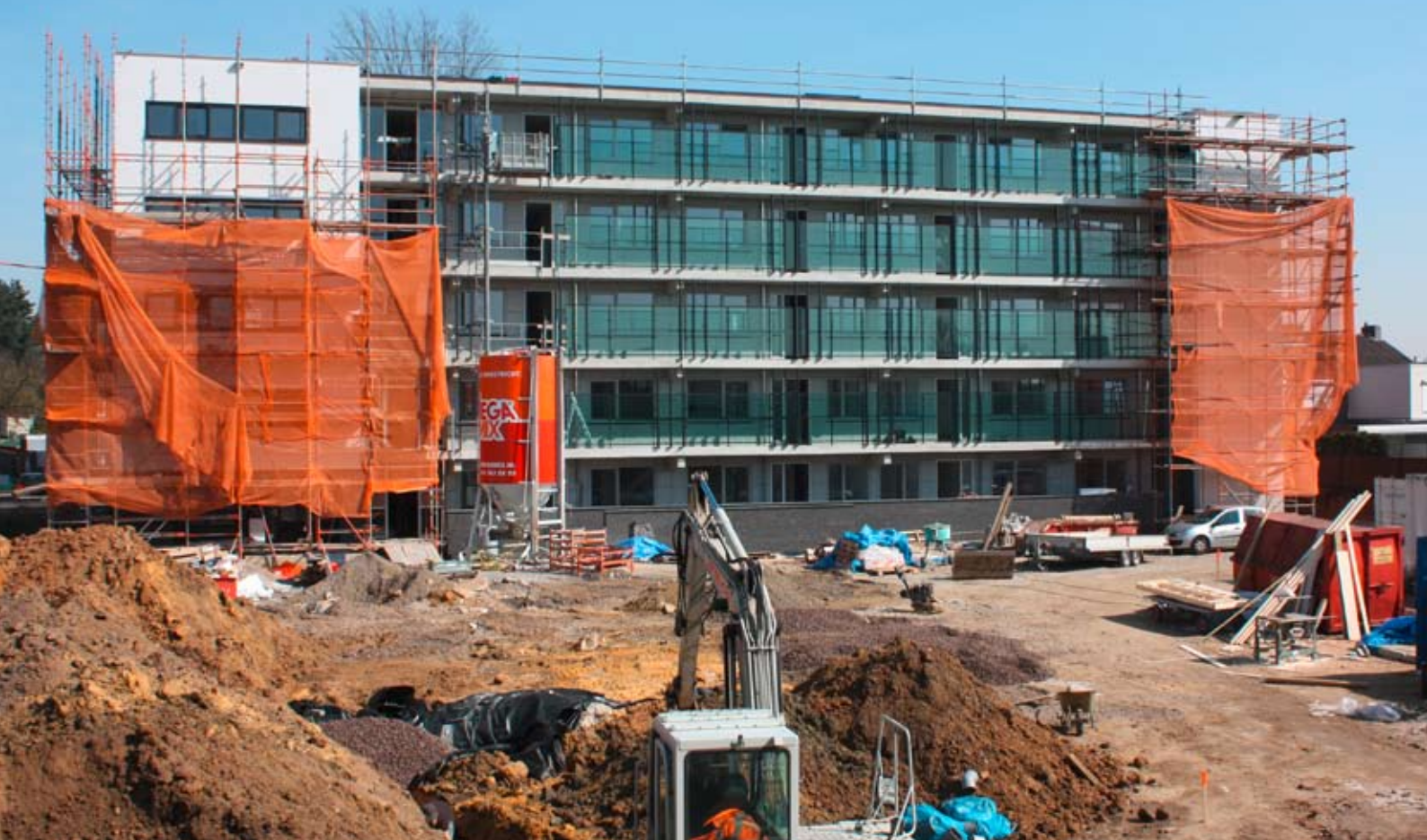
De buis-in-buis-techniek wordt toegepast in het nieuwbouwapartementencomplex Old Hickory.
