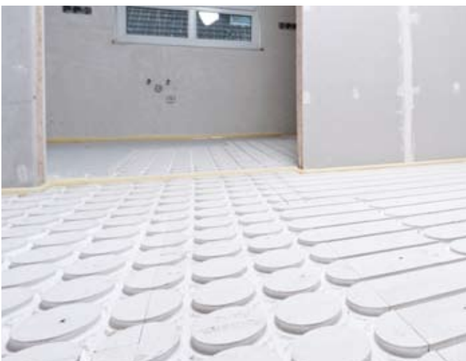
De systeemplaten en buigzame verwarmingsbuizen maken iedere configuratie mogelijk (boven). De platen hebben een opbouwhoogte van slechts 18 mm (links). Door de minimale opbouwhoogte sluiten de vloeren naadloos aan (rechts).
