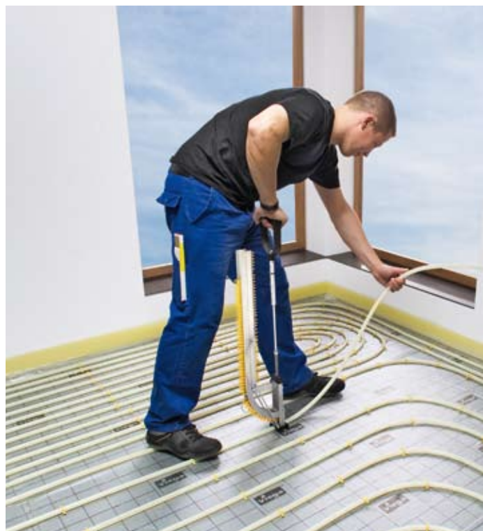
Met Viega Fonterra Tacker worden de buisleidingen eenvoudig, snel en onlosmakelijk bevestigd.
