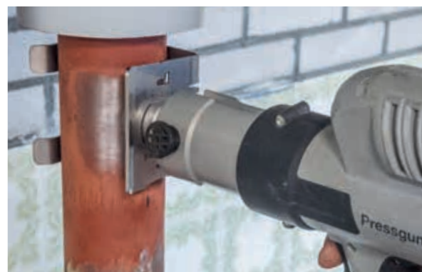
Met de persmachine kan nu de inpersaansluiting worden gemaakt.
