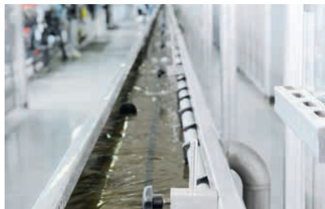
Productie in Niederwinkling: extrusie van volledig kunststofbuizen én van Inliner voor AKB-buizen.
