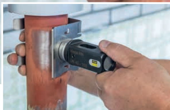
Vervolgens positioneerhulp plaatsen en inpersaansluiting met de inperstool positioneren.
