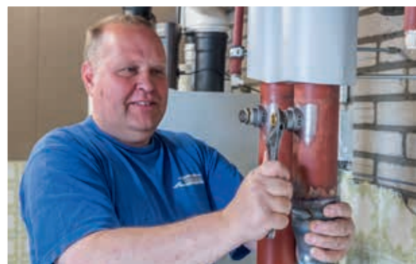
In de inpersaansluiting wordt de houder voor de voeler bevestigd.
