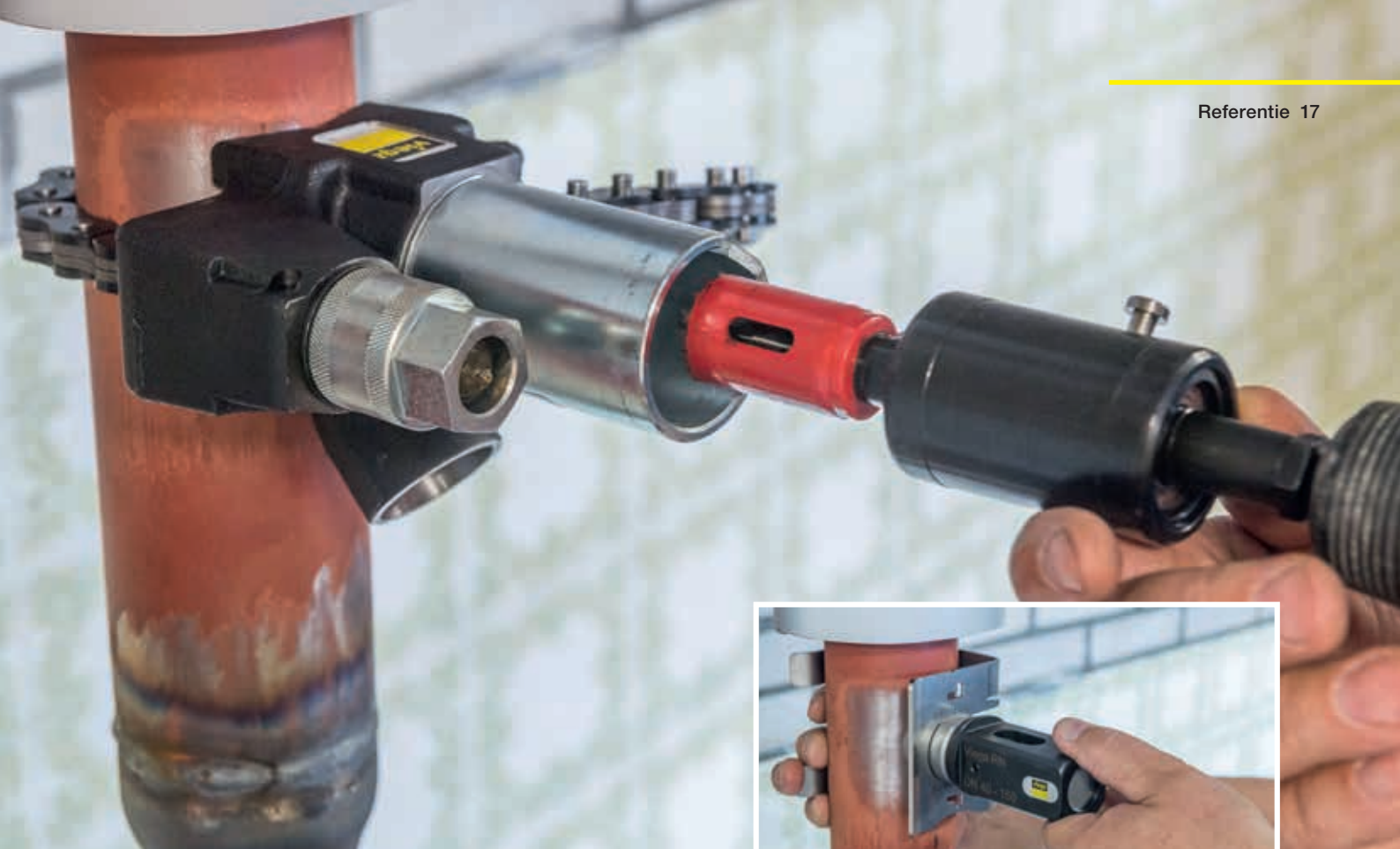
De montagehouder op de buis bevestigen en persopening boren door de boorkop met boorkroon in te voeren.
