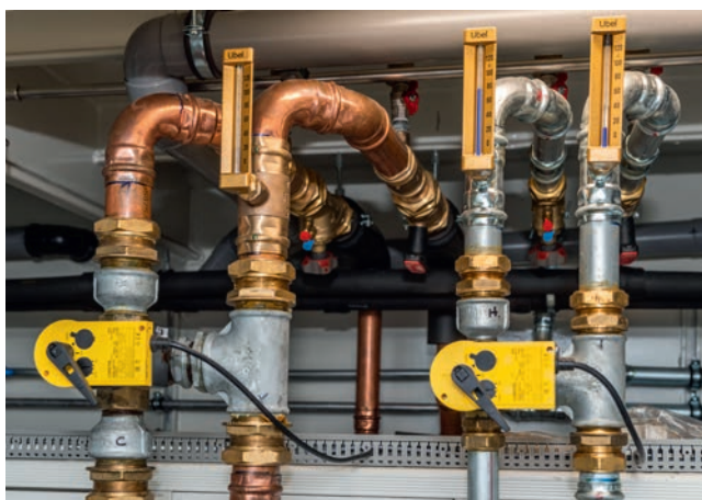
Op de 2 cruiseschepen werden de 2 perssystemen Prestabo en Profipress toegepast.
