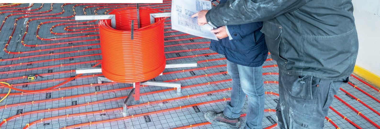
De Fonterra-vloerverwarmingsbuizen werden vastgezet met tackernagels.
