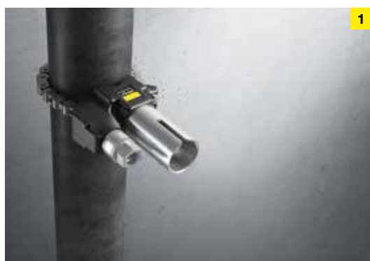
1. Een speciale boorgeleider wordt op de stalen buis bevestigd.
