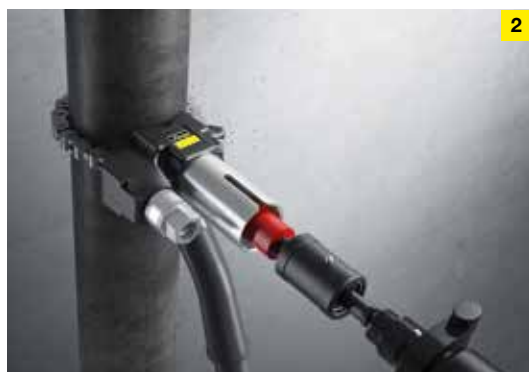
2. Boring uitvoeren met de boormachine en boorgeleider weer eraf halen.
