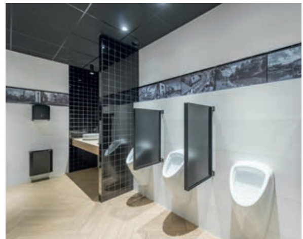
De fotostrip op ooghoogte staat in het teken van Breda. De sifon-sensortechniek van Viega zorgt daarbij voor een automatische en hygiënische spoeling van urinoirs.
