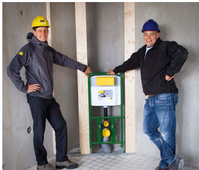
Projectleider Bert Wekema (r.) naast Ferdinand Wesselink: “Met Viega kan altijd op de eisen en wensen van installateur, gebruiker én omgeving worden ingespeeld.”
