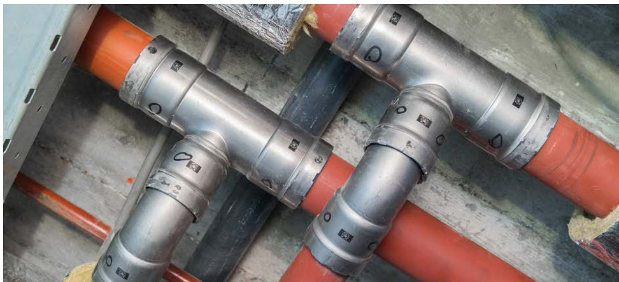
Ook in kleinere ruimten kunnen de dikwandig stalen buizen dankzij de Megapress-perstechniek veilig en snel worden verwerkt.
