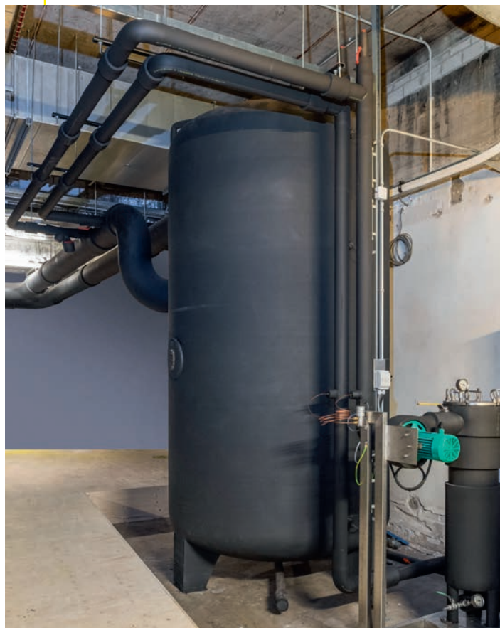
Door met Megapress te werken was er geen las- en slijpvergunning nodig in de technische ruimte.
