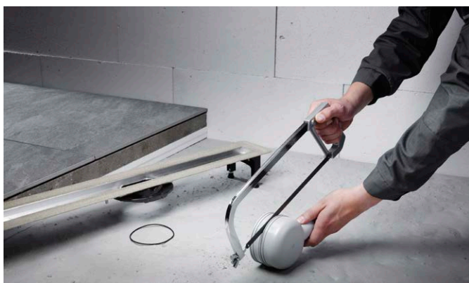
Door eenvoudig afzagen kan de standaardafvoer nog ter plekke worden veranderd in een renovatiemodel.
